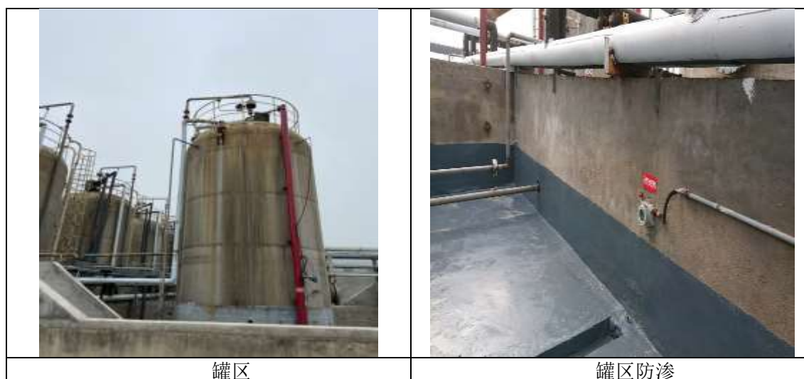
图 3.6.5-1 罐区现状照片
