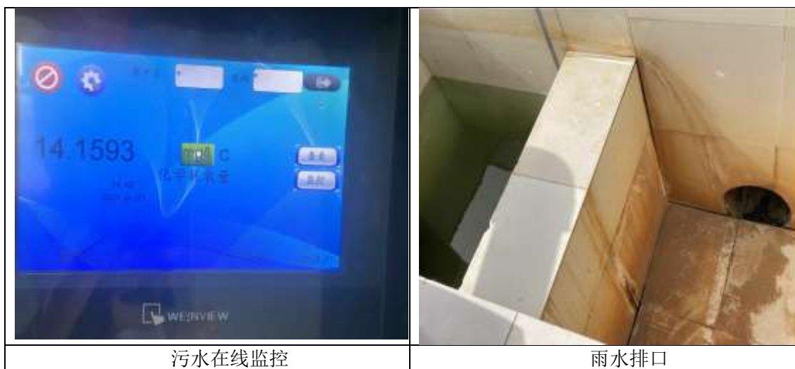
图 3.6.2-4 雨污排口现状照片
