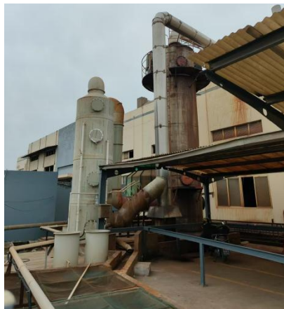
焙烧炉：水喷淋+湿式静电除尘+排气筒 DA001（DA012）
