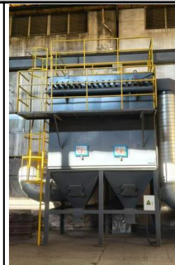
制芯、焙烧废气：集气罩+布袋除尘器+两级活性炭+排气筒 DA018 (DA023)
