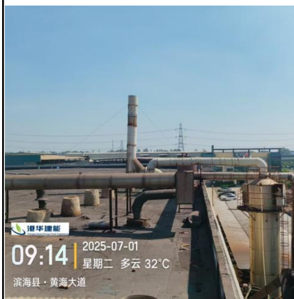
焙烧炉：水喷淋+湿式静电除尘+排气筒 DA001（DA012）
