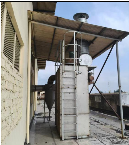
覆膜砂熔化、浇注布袋除尘器+排气筒 DA020 (DA024)
