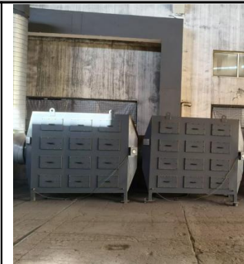
制芯、焙烧废气：集气罩+布袋除尘器+两级活性炭+排气筒 DA018 (DA023)
