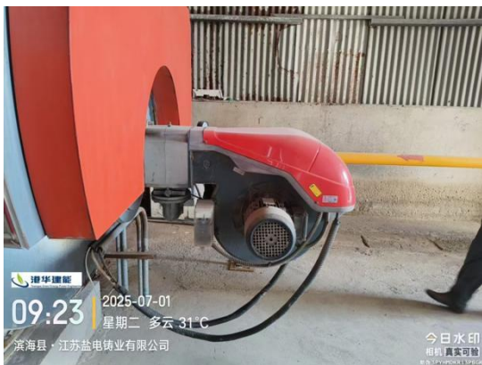
锅炉低氮燃烧器+排气筒 DA019 (DA019)
