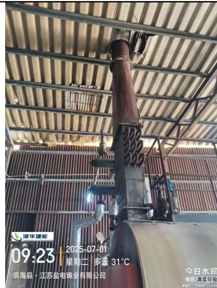
锅炉低氮燃烧器+排气筒 DA019 (DA019)
