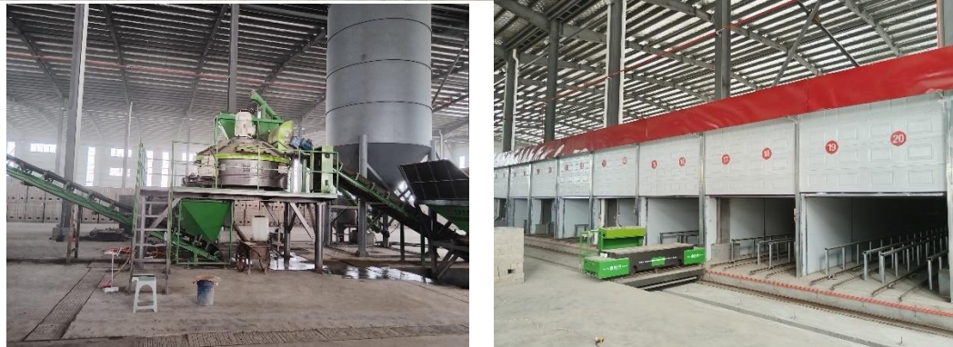
滨海县建筑垃圾资源化利用项目车间
